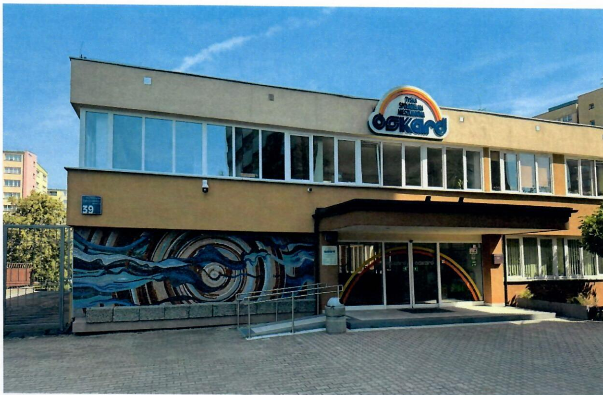
Fot. 2. Budynek TSM OSKARD, elewacja frontowa z mozaiką, stan z 2025 roku.
