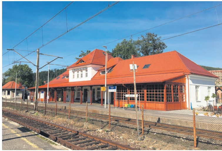
Wyremontowany budynek dworca Wisła-Uzdrowisko prezentuje się znakomicie.
