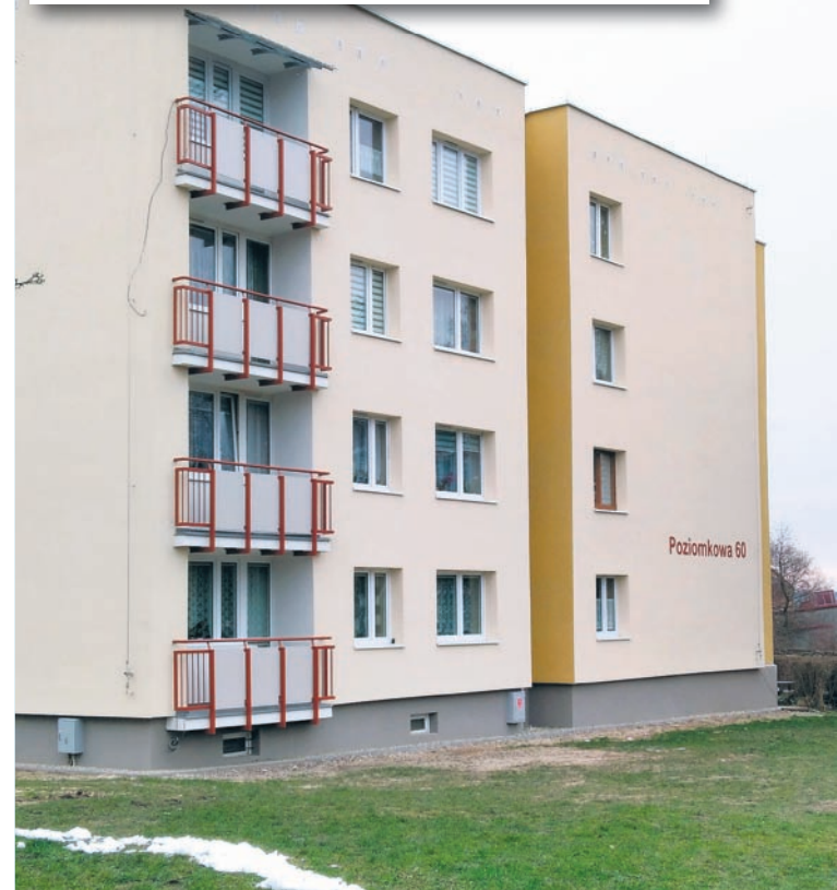
W rejonie GZM nr 4 w grudniu 2022 r. skończono prace budowlane związane z dociepleniem wraz z przebudową balustrad balkonowych w budynku przy ul. Poziomkowej 60.
