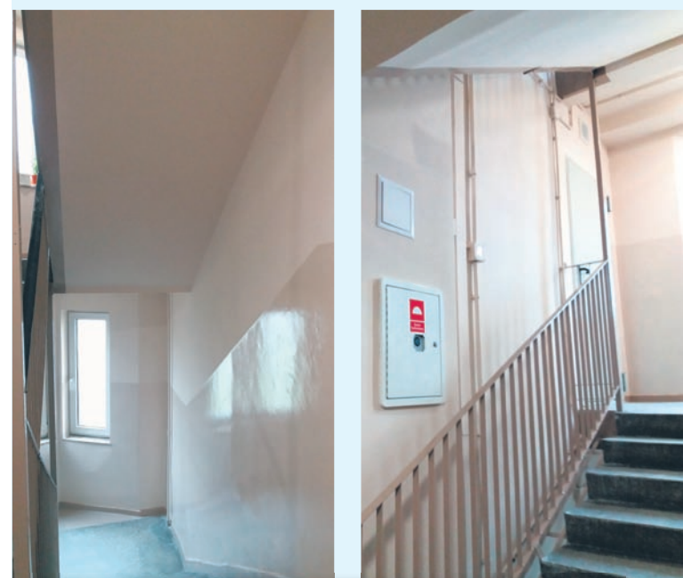
W Rejonie GZM Nr 7 zakończono prace związane z malowaniem klatek schodowych w budynku przy ul. Ujejskiego 3-9, powyższe prace wykonane zostały przez ZRB TSM „OSKARD”.
