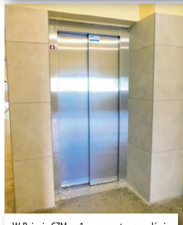
W Rejonie GZM nr 1 wyremontowano dźwign osobowy w budynku przy ul. H. Dąbrowskiego 5. Wymianie na nowe podlegały wszystkie podzespoły dźwigu tj. wciągarka, kabina oraz drzwi szybowe.
