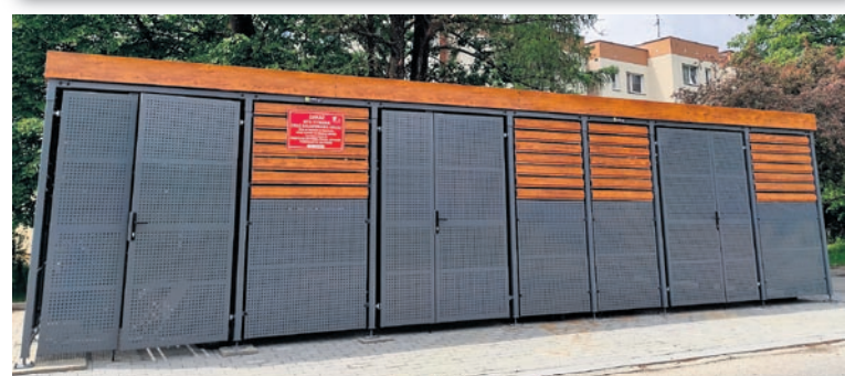
W Rejonie GZM nr 5 przy ul. E. Orzeszkowej 17-29 powstała nowa altana śmietnikowa. Altanę sfinansowano ze środków przyznanych w ramach budżetu obywatelskiego na 2022 r. Dziękujemy wszystkim, którzy oddali głos na ten projekt.
