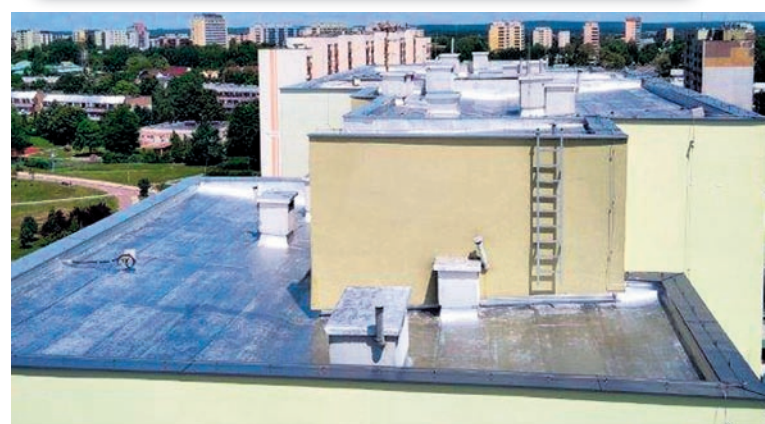
Na przełomie maja i czerwca 2022 roku w budynku mieszkalnym wielorodzinnym przy ul. S. Jaracza 7-9 w Rejonie GZM nr 4 wykonano zabezpieczenie pokrycia połaci dachowej. Roboty sfinansowano ze środków gromadzonych na funduszu remontowym nieruchomości budowlanej nr 2. W kolejnych miesiącach ten sam zakres prac wykonany zostanie w budynku mieszkalnym wielorodzinnym przy ul. S. Jaracza 11-13.
