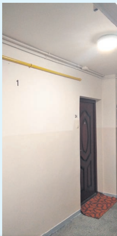
Rejon GZM nr 1, ul. Wyszyńskiego 56-58 – klatki schodowe i korytarze pomalowano farbą emulsyjną, a lamperie farbą olejną, na parterze budynku położono także tynk mozaikowy.
