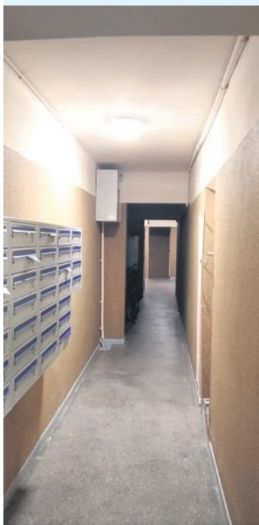
Rejon GZM nr 1, ul. Wyszyńskiego 56-58 – klatki schodowe i korytarze pomalowano farbą emulsyjną, a lamperie farbą olejną, na parterze budynku położono także tynk mozaikowy.
