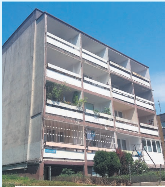
Od lipca do października 2021 roku w budynkach Rejonu GZM nr 4, przy ul. Poziomkowej 50 i 52 wykonano termoizolację ścian zewnętrznych wraz z robotami towarzyszącymi. Zakres prac obejmował demontaż istniejącego ocieplenia, kotwienie warstwy fakturowej do warstwy nośnej prefabrykatu, naprawę płyt stropowych balkonów i loggii oraz wykonanie warstwy wierzchniej z uwzględnieniem obróbki blacharskiej, ocieplenie ścian, montaż zadaszeń nad balkonami ostatniej kondygnacji, a także wymianę balustrad balkonów i loggii, montaż nowej instalacji odgromowej. Roboty sfinansowano ze wsparciem pożyczki z Wojewódzkiego Funduszu Ochrony Środowiska i Gospodarki Wodnej w Katowicach.
