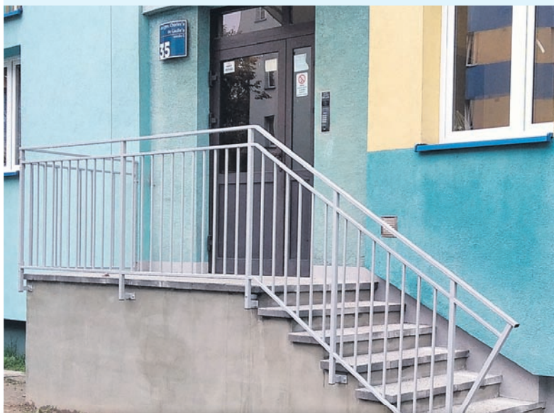
Rejon GZM nr 1, ul. De Gaulle'a 35 – rozbiórka schodów o konstrukcji wspornikowej, wykonanie konstrukcji betonowej na fundamencie oraz wykończenie schodów i podestu płytkami z montażem nowej balustrady.
