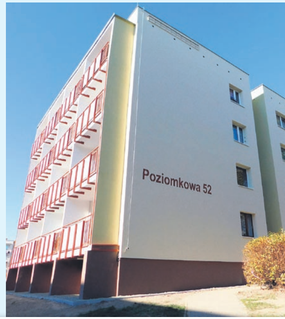
Od lipca do października 2021 roku w budynkach Rejonu GZM nr 4, przy ul. Poziomkowej 50 i 52 wykonano termoizolację ścian zewnętrznych wraz z robotami towarzyszącymi. Zakres prac obejmował demontaż istniejącego ocieplenia, kotwienie warstwy fakturowej do warstwy nośnej prefabrykatu, naprawę płyt stropowych balkonów i loggii oraz wykonanie warstwy wierzchniej z uwzględnieniem obróbki blacharskiej, ocieplenie ścian, montaż zadaszeń nad balkonami ostatniej kondygnacji, a także wymianę balustrad balkonów i loggii, montaż nowej instalacji odgromowej. Roboty sfinansowano ze wsparciem pożyczki z Wojewódzkiego Funduszu Ochrony Środowiska i Gospodarki Wodnej w Katowicach.
