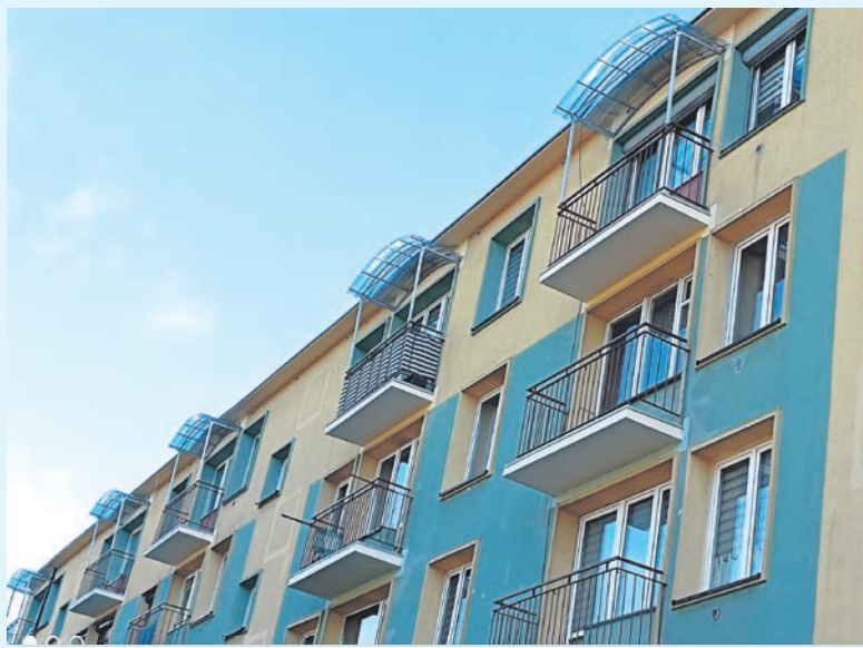
Zakończyliśmy prace związane z remontem płyt balkonowych, malowaniem balustrad oraz zadaszeniem balkonów na ostatniej kondygnacji strony zachodniej budynku mieszkalnego w Rejonie GZM nr 3, przy ul. Elfów 31-37. Prace zostały wykonane przez nasz Zakład Remontowo-Budowlany.
