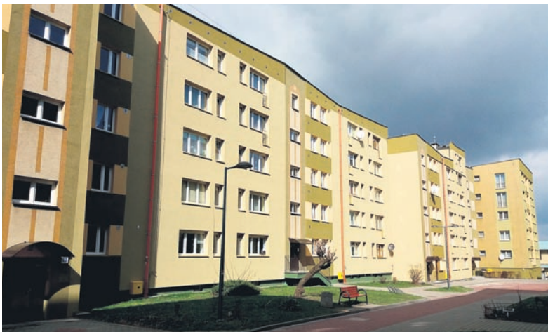
W skład Rejonu GZM nr 1 wchodzi m.in. budynki przy ul. gen. Ch. de Gaulle’a 3-9.
